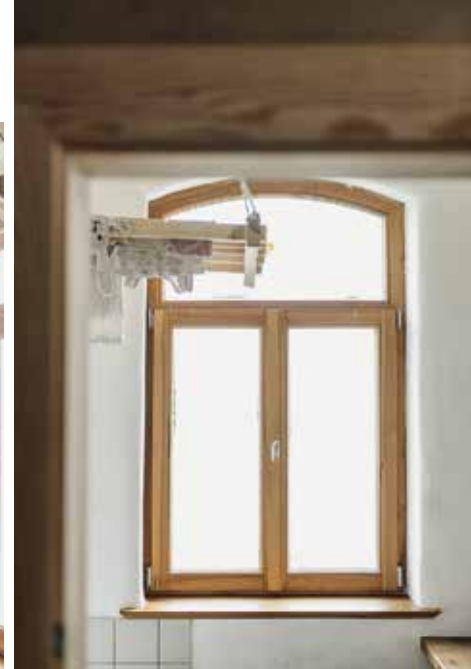
Die Holzfenster im Bad sind von außen im hellgrauen Leinölfarbtönen gestrichen, wurden aber von innen in Natur belassen und nur geölt. Ein aufgeklebter Sichtschutz hält Blicke von draußen fern.
