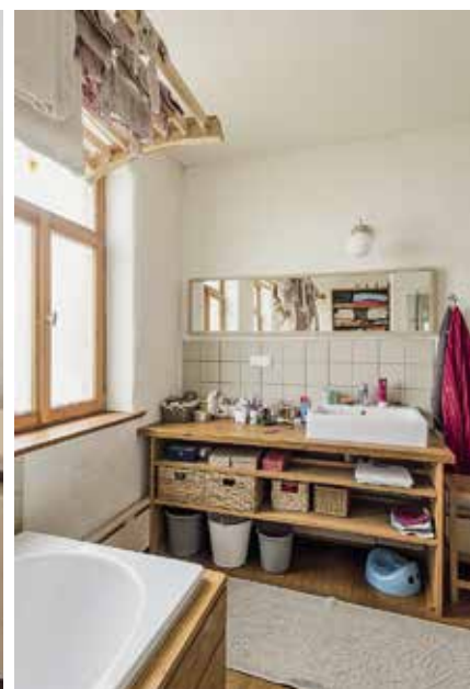
Die Wanneneinfassung, der Waschtisch und das Wandregal sind aus massiver Eiche vom Zimmerer gebaut.
