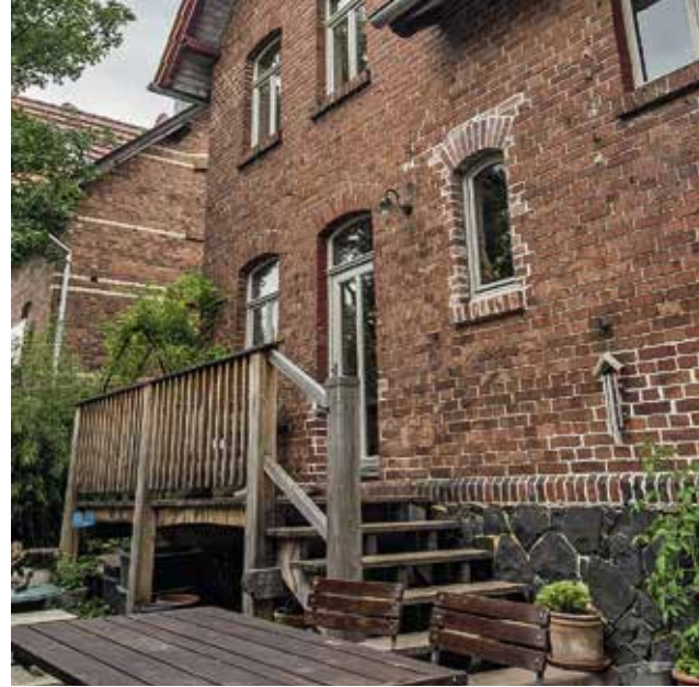
Hausansicht von der Straße
