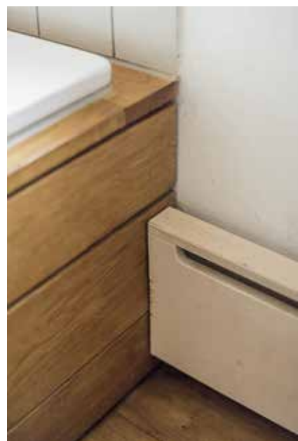
Die Sockelleistenheizung im Bad ist mit weiß geöltem Furniersperrholz ummantelt und grenzt an die Wanneneinfassung.
